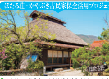
志和地区の茅葺古民家を地域交流拠点として図書室に。屋根材の茅を用意するために茅場の再生にもとり組む
